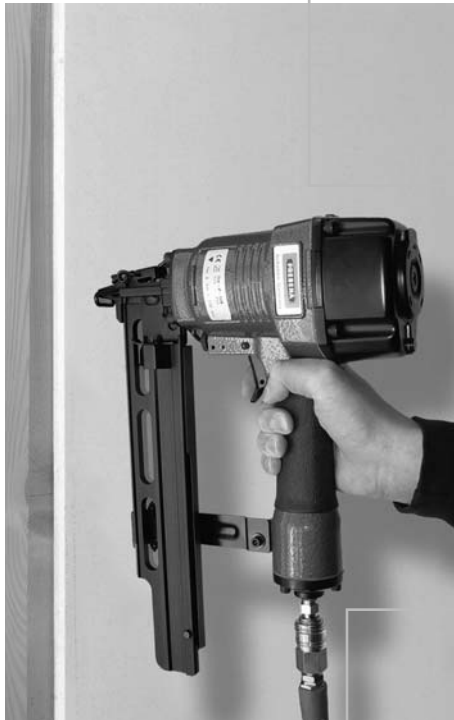
Klammern auf Holzunterkonstruktion
