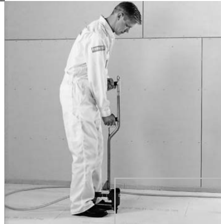
Rationelles Verarbeiten durch Klammern im Bodenbereich
