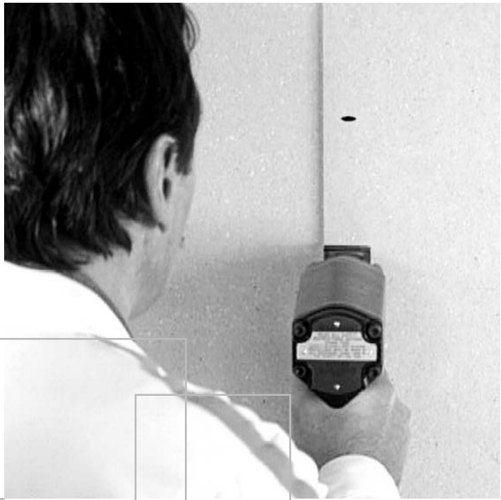
Klammern FERMACELL Gipsfaser-Platte auf FERMACELL Gipsfaser- Platte
